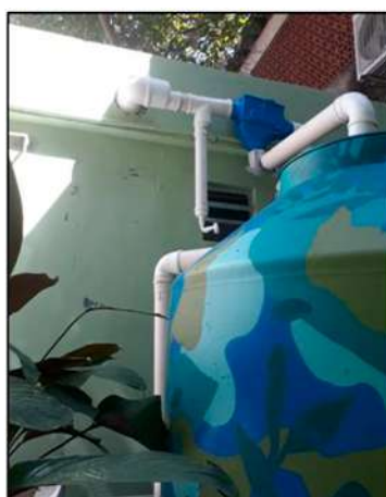
Figura 3B: Caixa e filtro instalados
